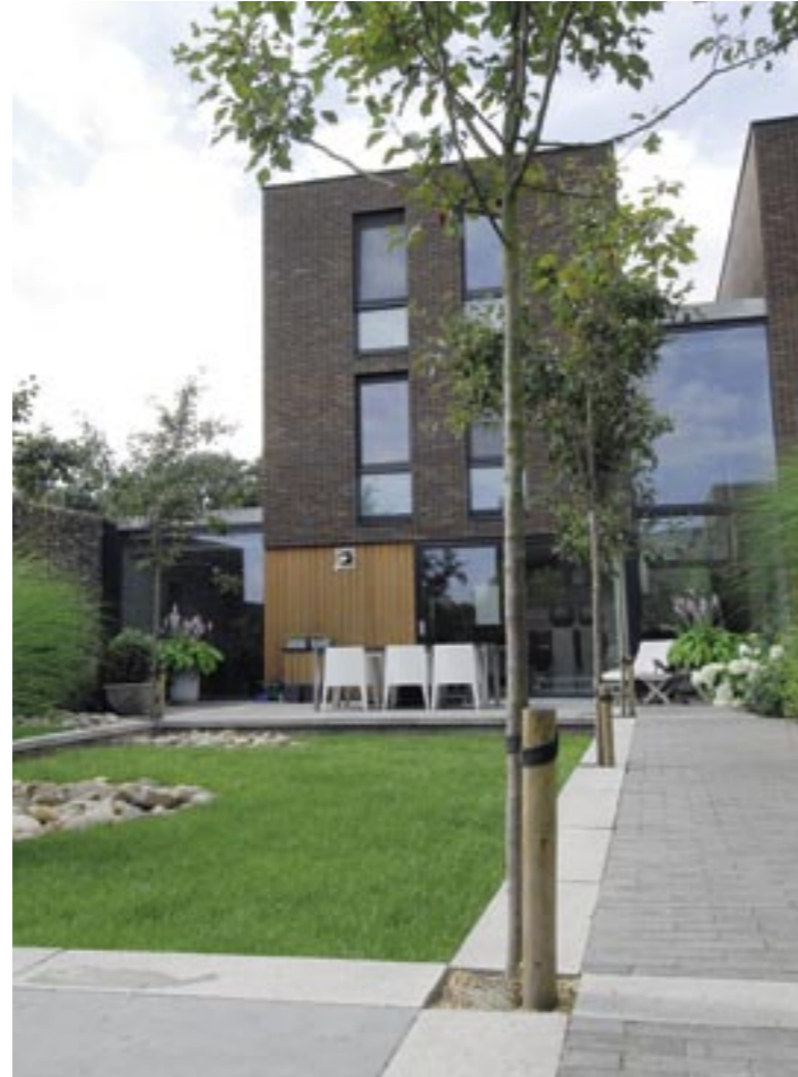
Drie soorten bestrating zijn gebruikt: betonnen opsluitbanden, vierkantemeter-tegels van Chinees hardsteen en antraciet dikformaat van Schellevis.
